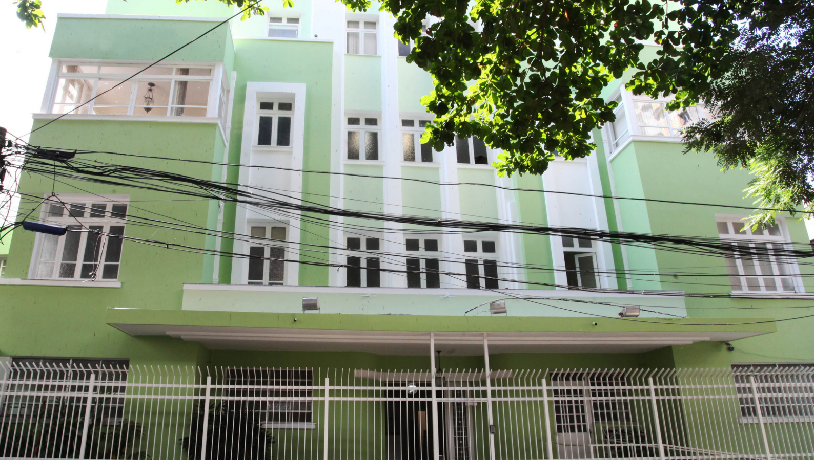
Prédio sede do RioSolidario já reformado
